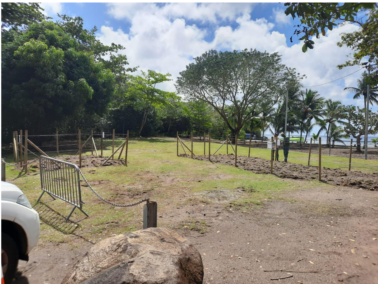
Figure 5 - Installation des enclos en quinconce au niveau du parking, le 10 février 2023
