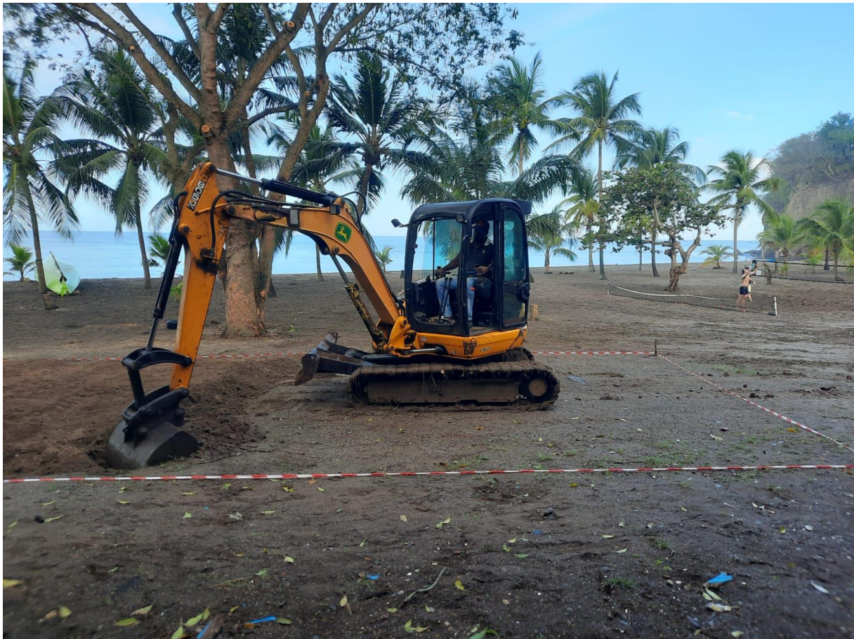
Figure 4- Décompactage au niveau de l'enclos au Sud de la plage, le 9 février 2023.
