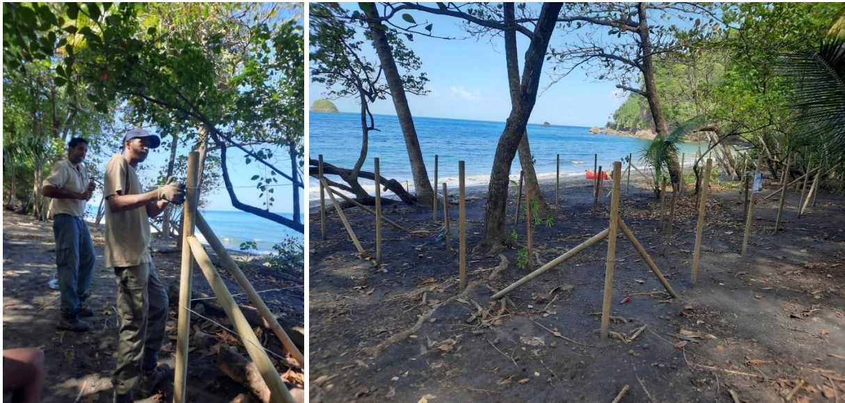
Figure 12- Installation des enclos sur la plage de l'Anse Céron par les ouvriers forestiers de l'ONF
