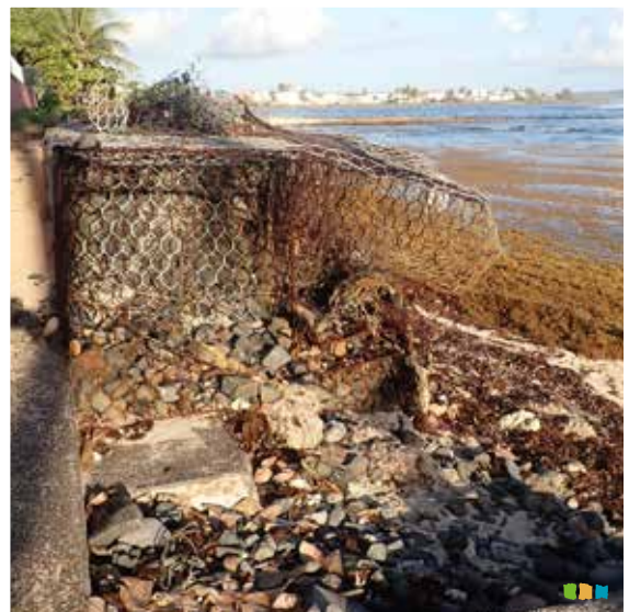
Gabions 2015 de la résidence de l'Autre Bord, détériorés avec perte de substrat (roches d'origine volcanique non originaires de la Grande Terre).
