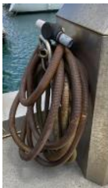
Figure 14 : Photo du tuyau d'une pompe à eaux grises et eaux noires de la marina de l'Etang Z'Abricot
